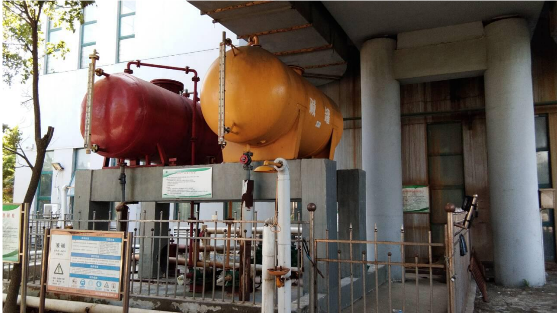
图 4.5 危险化学品储罐区示意图
