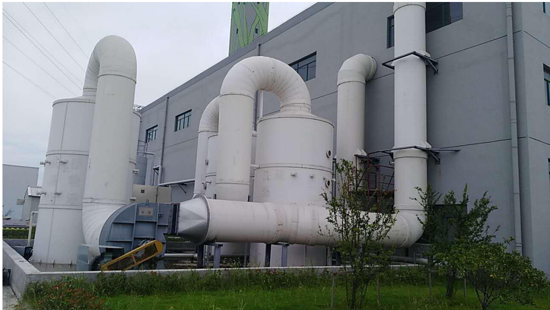
图 4.3 废气处理设施图
